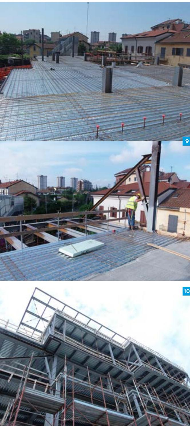
9. Vista dell'impalcato di solaio del piano primo e del piano terzo durante la fase di predisposizione della lamiera grecata e del relativo getto collaborante.
